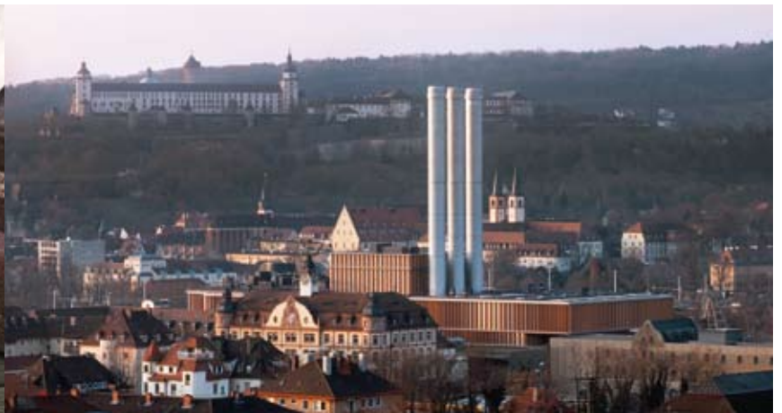
HKW Würzburg – begutachtet durch Müller-BBM
